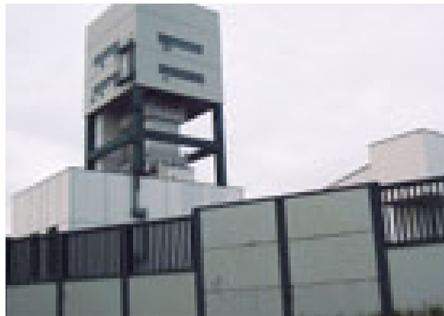
Il./Fig. 13. Kopalnia Gorleben / Gorleben Mine Fot./Photo by G. Czapowski
